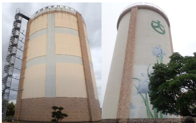
Fig. 2 野外調査を実施した用水吐水槽 (左: 藤田揚排水機場, 右: 大曲揚排水機場)
